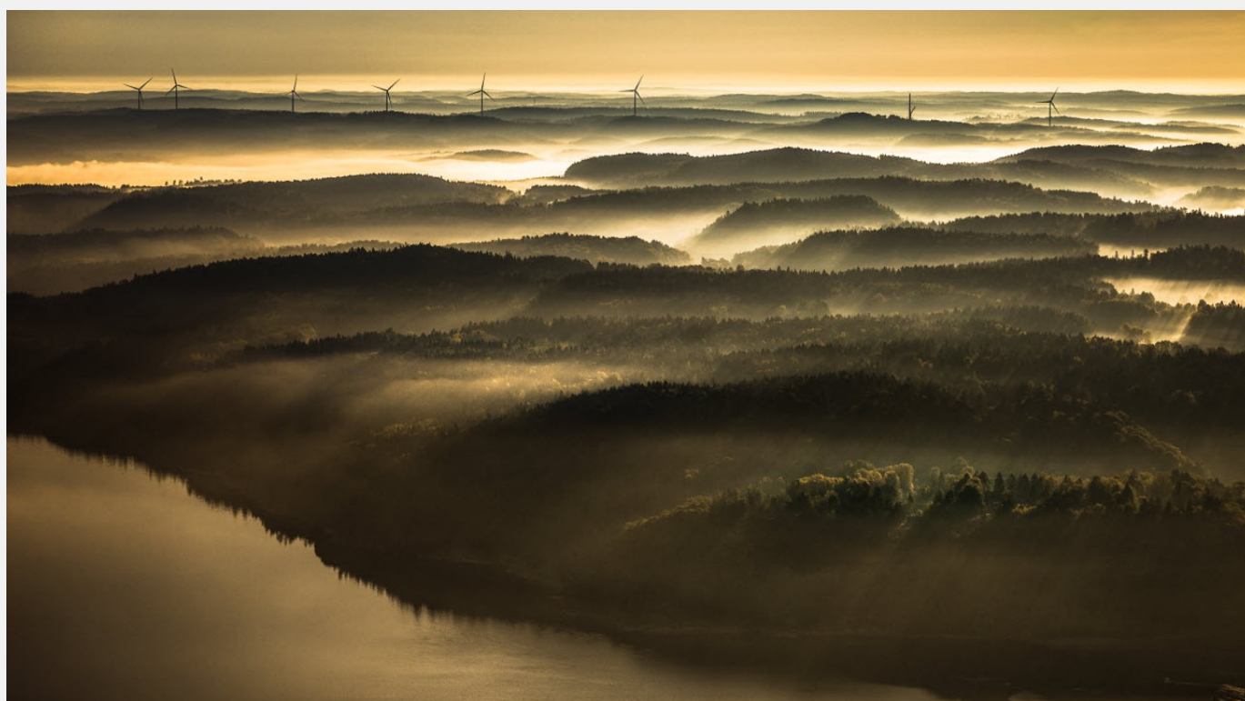
Gunnarby vindkraftpark - Uddevalla
