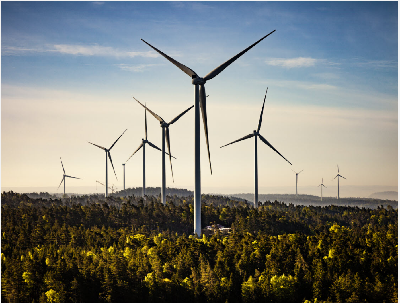
Gunnarby vindkraftpark - Uddevalla
